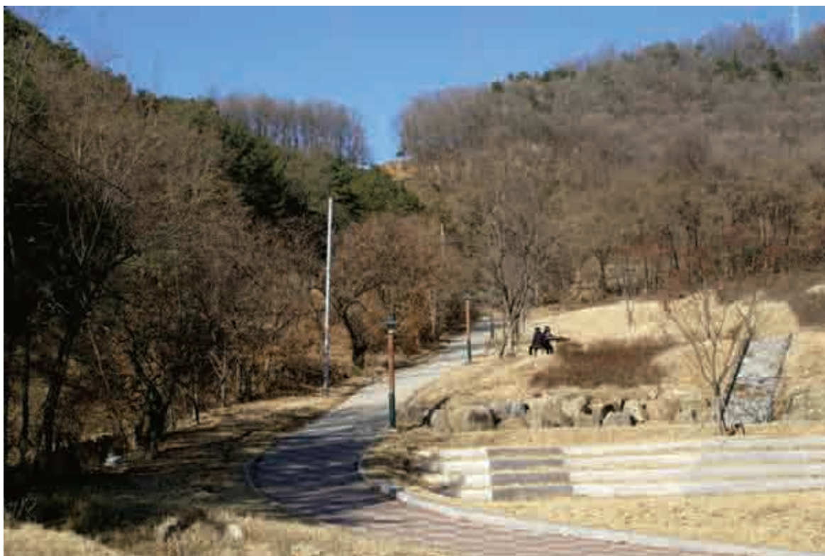
【사진 4】 공사구간 초입부(가양공원)
