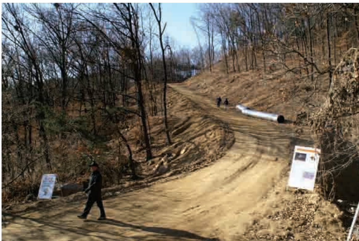
【사진 5】 1구간 공사 시점부(동에서)
